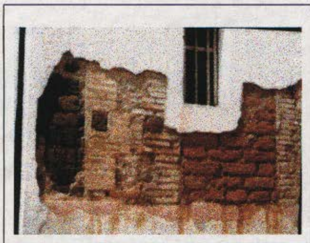
Muros de Adobe
